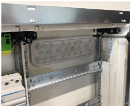
An Schrankrückseite montierter staubdichter Flansch VZ741
