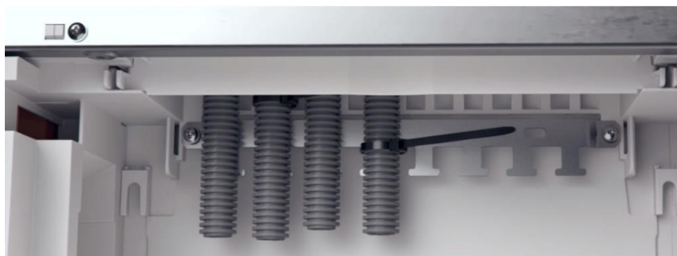
Befestigung von Rohren und Leitungen an der montierten Kabelabfangschiene FZ850F
