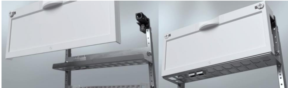
Einbau der Patchpanel-Abdeckung mit 2 Turmoberteilen
