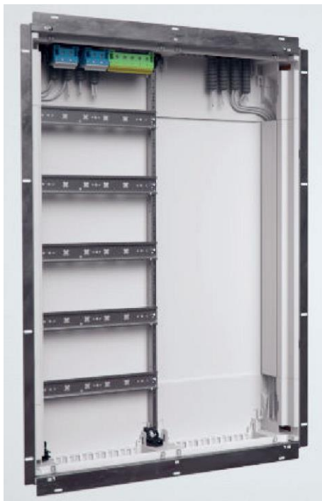
Montierter Deckel auf rechtem seitlichen Kabelkanal
